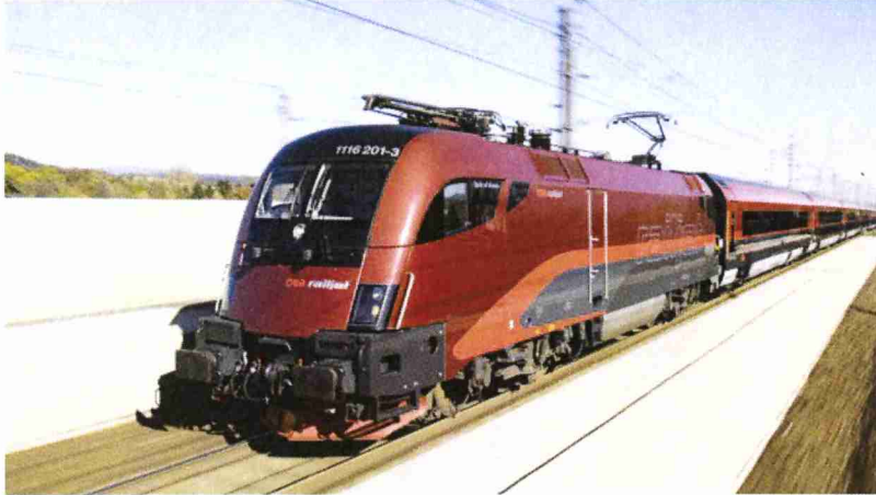
Die Bahnstrecke zwischen Marchtrenk und Linz soll von zwei auf vier Gleise erweitert werden.
